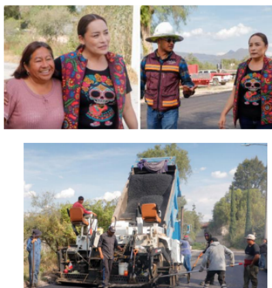
BOLETÍN 203 3-11-2025 OBRA DE PAVIMENTACIÓN EN TLAMACO
